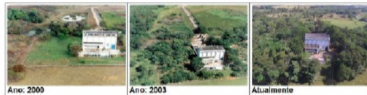
Figura 71 - Evolução do reflorestamento da captação da Saneago no Rio Meia Ponte em Goiânia (vista frontal) | Fonte: Saneago, 2018
