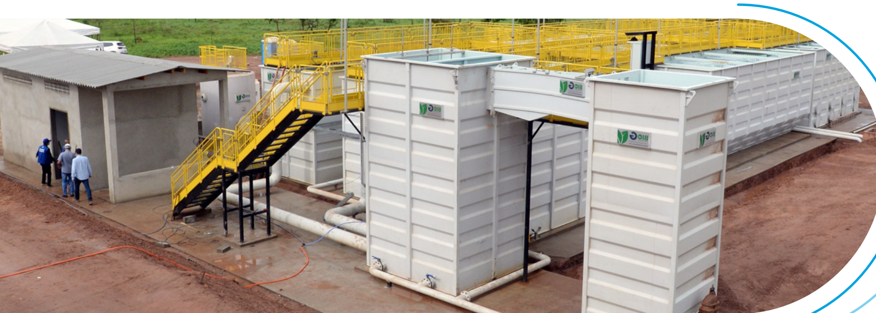
Uruaçu - Vistoria de obras da ETA Compacta - Acervo Saneago.
