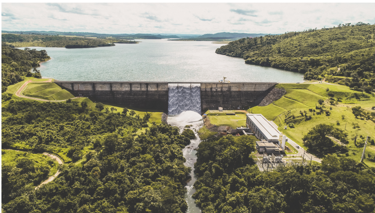
Figura 15 - Barragem do Ribeirão João Leite Fonte: Saneago
